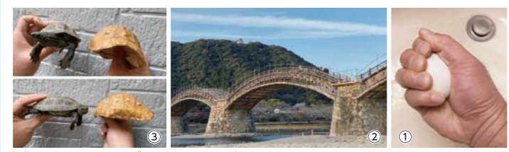
①指さえ立てなければ、手に包み込んだ生卵を思い切り握っても潰れません。念のため、シンクや風呂場で実験してください。②工事中で内部のアーチ構造が見える錦帯橋(山口県岩国市)。③水生のクサガメ(左)とリクガメ類の甲羅標本(右)。水生のカメの甲羅は平たく重い。陸生のカメはアーチ状で軽い。
